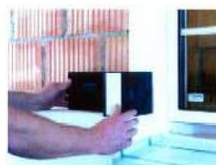
Une fois le mortier adhésif durci, appliquer les fixations mécaniques.
