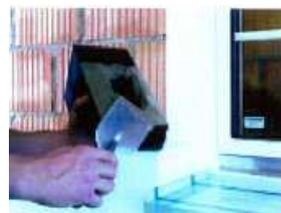
Presser MTH ELEMENT DE FIXATION EXTERNE EBRASEMENT K1-PH au ras des panneaux isolants, dans la partie fraisée.
